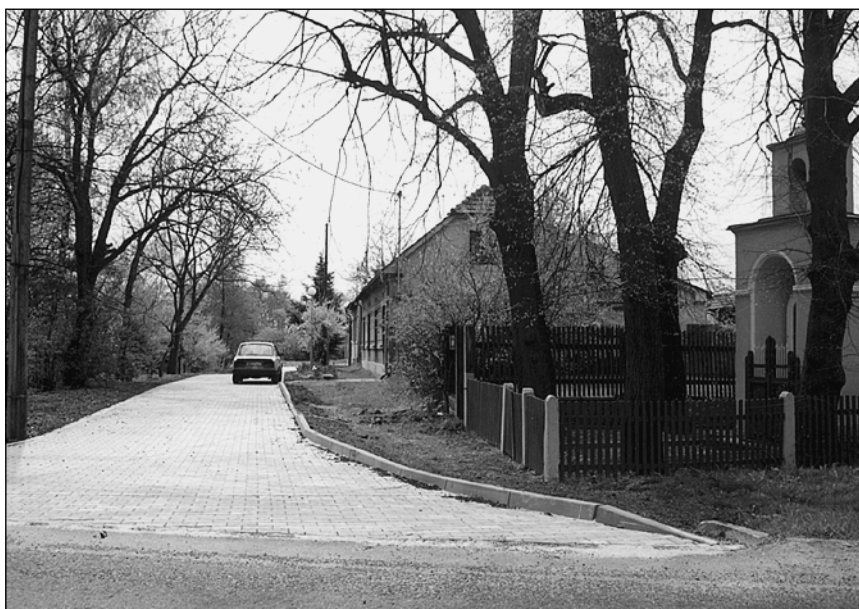
Rekonstrukce ulice v Rozkoší je dokončena.
